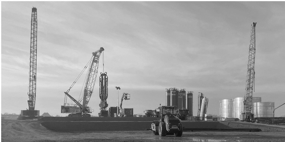
Abbildung 5: ElbX - Schlitzwandarbeiten für das Schachtbauwerk in Wewelsfleth (Bild: Planungsgemeinschaft ElbX – WTM Engineers | BabEng; November 2023)
