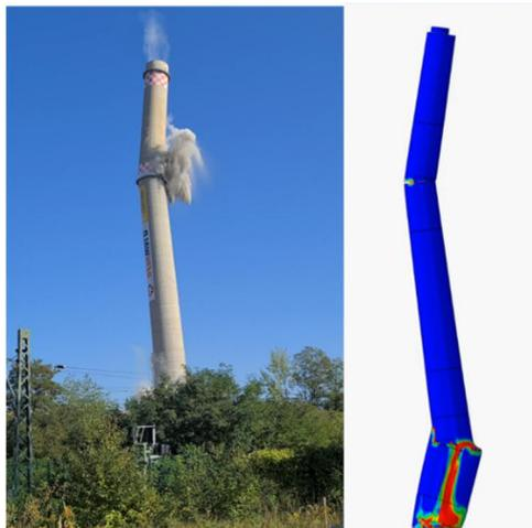
**Abbildung 10:** Simulation vs. Realität: unmittelbarer Vergleich nach der Sprengung
