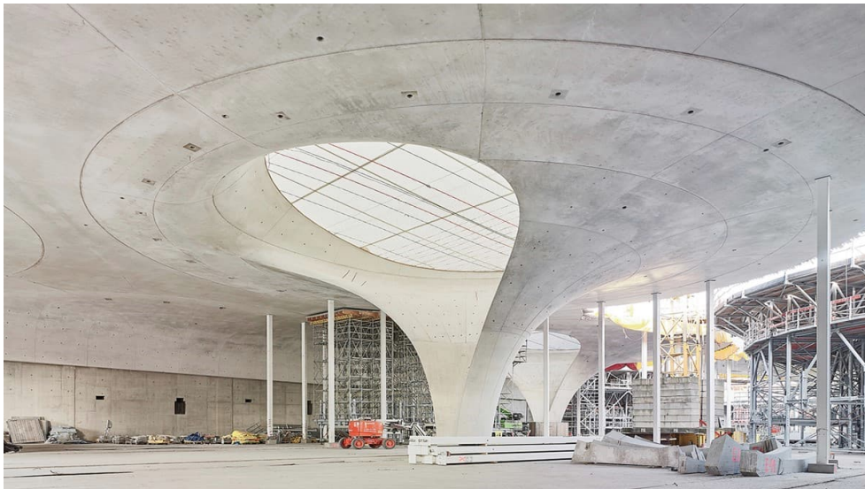
Abbildung 9: In Teilbereichen fertig gestelltes Schalendach mit Notunterstützung (Foto: Arnim Kilgus / DB)
