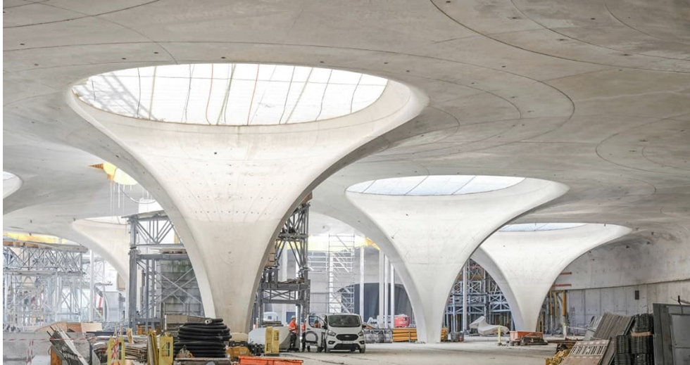
Abbildung 7: Der Beton C 50/60 mit Weißzement, geringer Hydratationswärmeentwicklung, PP-Fasern und Sichtbetonqualität SB 4
