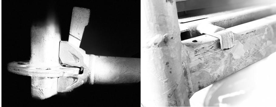
**Abbildung 1:** Verbindungen im Gerüstbau: Modulknotten (links), horizontale Ebene (rechts)
