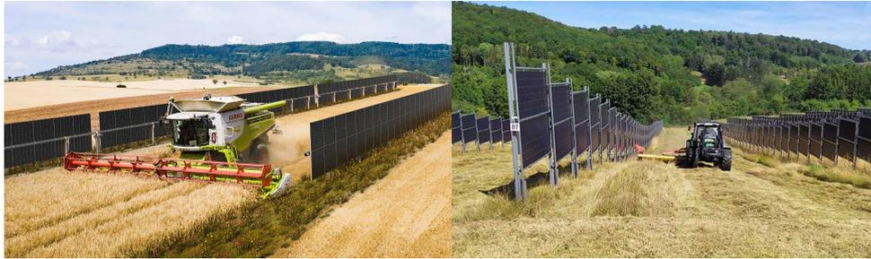
**Abbildung 2:** herkömmliches Freilandssystem der BayWa r.e. (links, Bild ©BayWa r.e.) und senkrechter „Solarzaun“ der Next2Sun GmbH (rechts, Bild ©Next2Sun GmbH)
