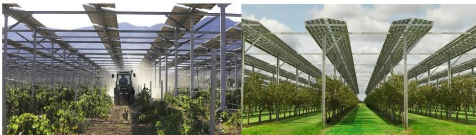
**Abbildung 3:** Geometrie herkömmlicher Freilandsysteme mit großer Bauhöhe (Bilder: links ©Sun'Agri SAS, rechts ©voestalpine Sadef)
