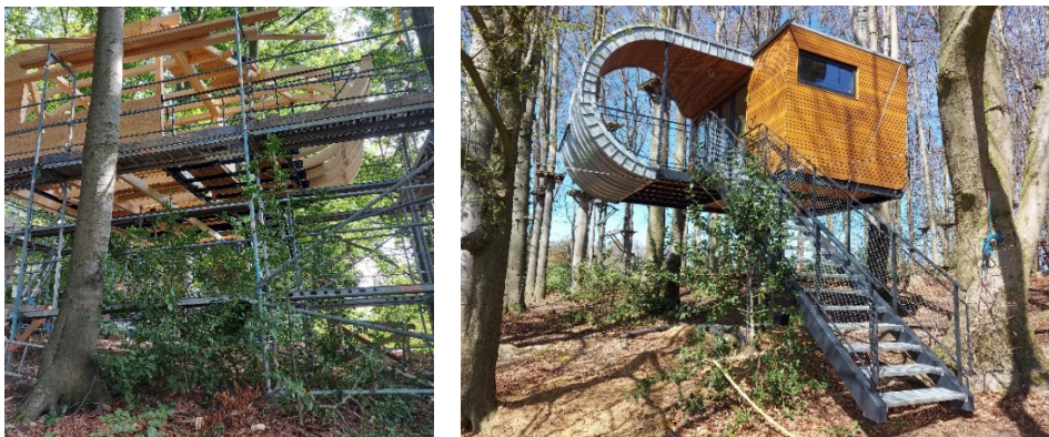
Abbildung 2: Bauzustand sowie fertiggestellter, freihängender Wohnkörper mit Treppenaufgang
