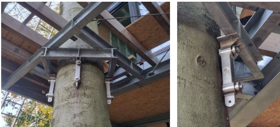
Abbildung 6: Umreifung zur Integration des Tragbaumes
