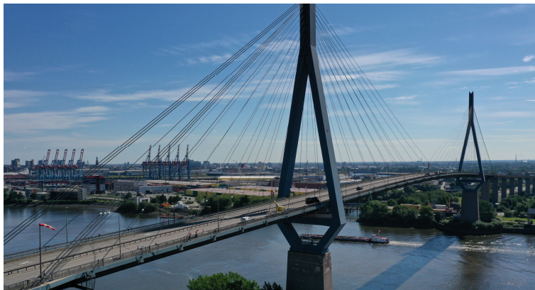
Abbildung 2: Blick auf die Köhlbrandbrücke im Hamburger Hafen Foto: HPA
