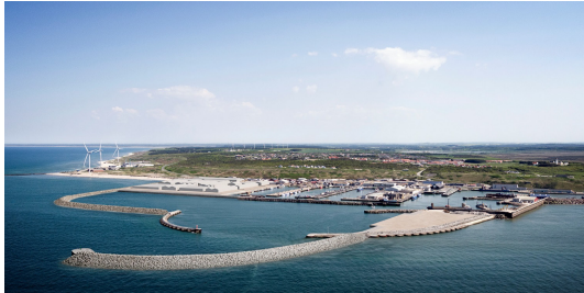
(a) Einsatz von Wellenbrechern in Hanstholm (Dänemark), entnommen aus [10]
