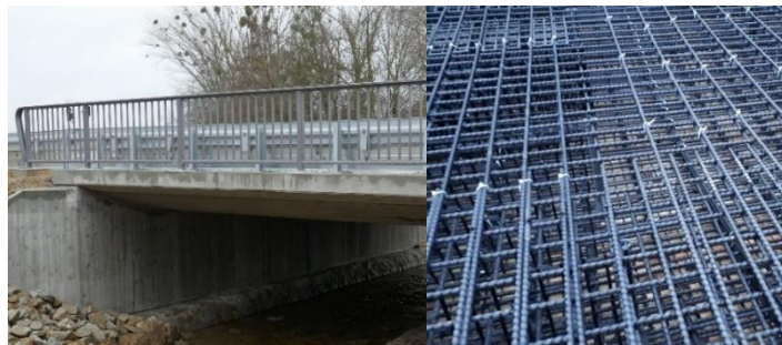
Abbildung 3: links: Straßenbrücke für den Schwerlastverkehr vollständig aus Carbonbeton; rechts: Bild von den Carbonstäben; Foto: CARBOCON, Enrico Lorenz
