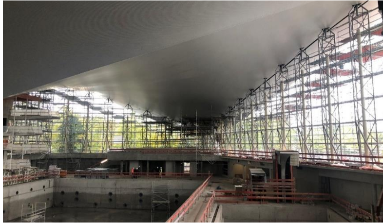
Abbildung 4: Foto Fassade während der Bauzeit © sbp/Sebastian Grotz
