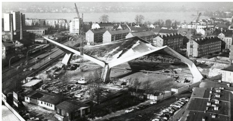
Abbildung 1: Die freistehende Dachschale während der Errichtung © Bäderland Hamburg
