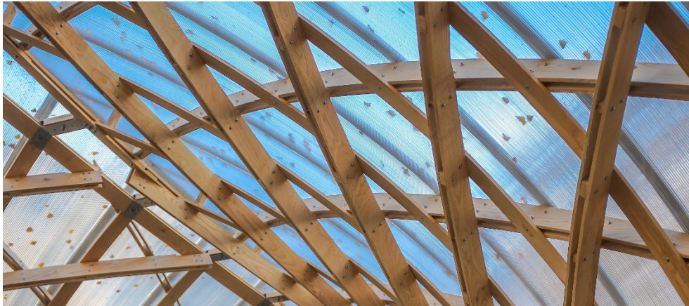
Abbildung 1: Holzkuppel aus baugleichen Teilen. Die Gitterschale wurde aus gleichförmigen Eschenlatten, hexagonalen Knotenstäben und abwickelbaren Polycarbonatplatten konstruiert.
