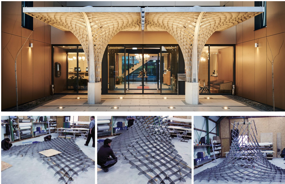
Abbildung 2: Asymptotisches Gitter des Hotel Intergroup in Ingolstadt. Die geraden Stahllamellen wurden eben ineinandergesteckt und anschließend in die räumliche Form gebogen [3].
